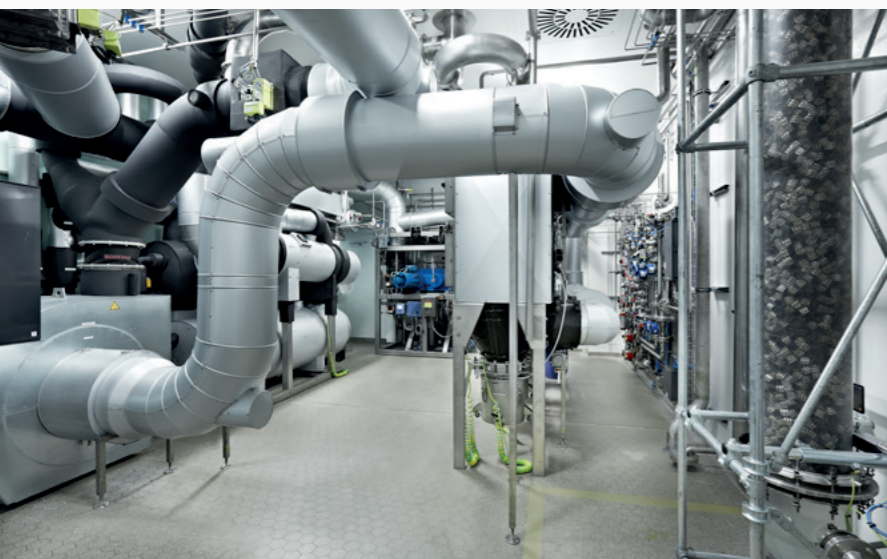
Technikbereich einer Coatinganlage mit Stickstoffkreislauf und Lösemittelkondensation
