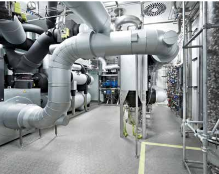
Technikbereich einer Coating-Anlage mit Stickstoffkreislauf und Lösemittelkondensation
